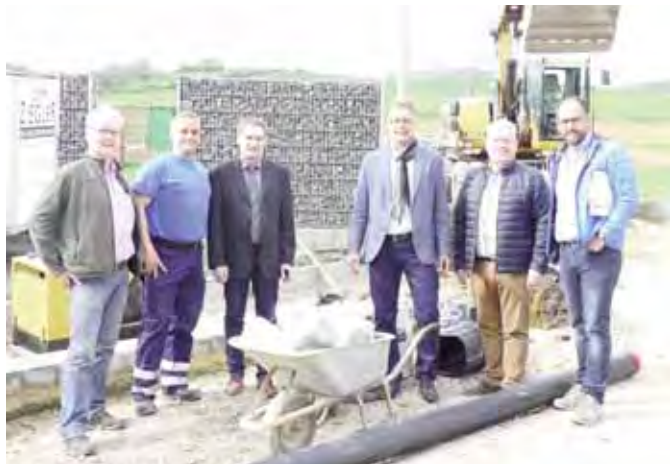
Das Foto zeigt Bürgermeister Hürtgen, Ortsvorsteher Körtgen, Herr Kochs vom bauleitenden Ing.-Büro Dr. Jochims & Burtscheid, Herr Hochgürtel von der bauausführenden Firma H & P Schilles und Beigeordneten Voigt bei der Ortsbesichtigung.
